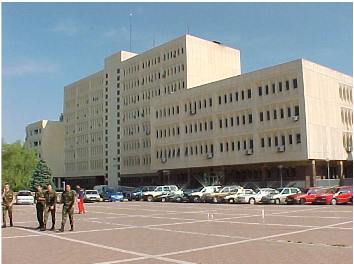
VISTA ACTUAL DEL EDIF. DE DEPENDENCIAS (CENTRO), DELEGACIÓN DE DEFENSA (DERECHA) Y PABELLONES DE CARGO (IZQUIERDA)
